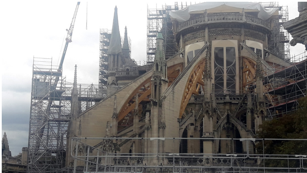
Le chantier de la cathédrale depuis la base vie (Moulis, 2019).
